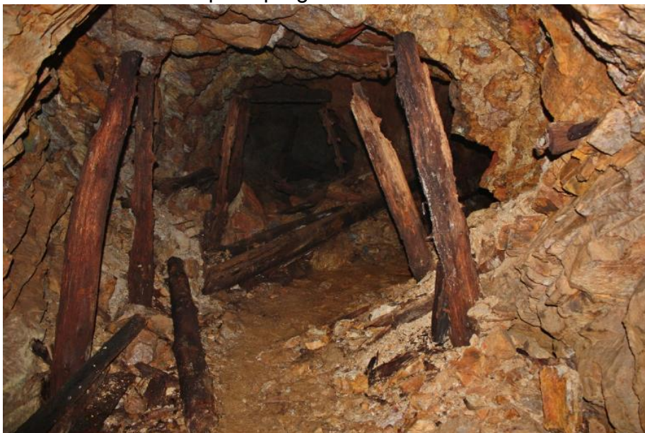
Slika 1.14 – Objekt 6 – pogled v progo 6a od objekta 5 proti 6e (avgust 2016)
