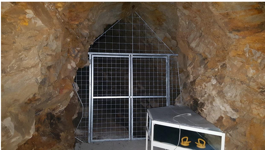
Slika 3.24 – Objekt 9 – Ograja z dvokrilnimi vrati pred vstopom v vpadnik 9
