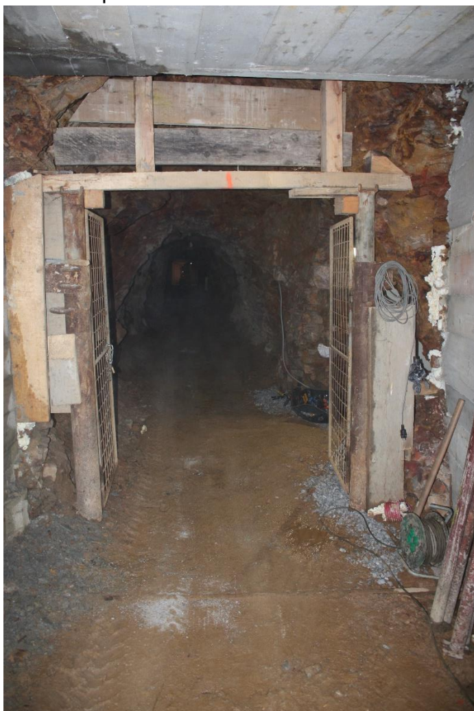
Slika 3.4 – Prehod iz portala v jamo proti Objektu 2
