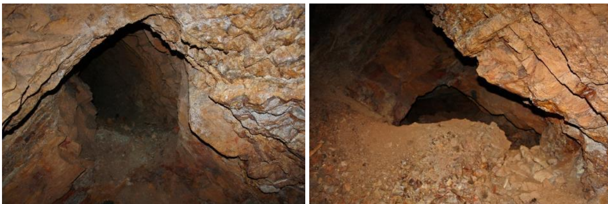
Slika 1.12 – Objekt 4c-levo proga proti S, desno zrušek tal v vpadnik (avgust 2016)
