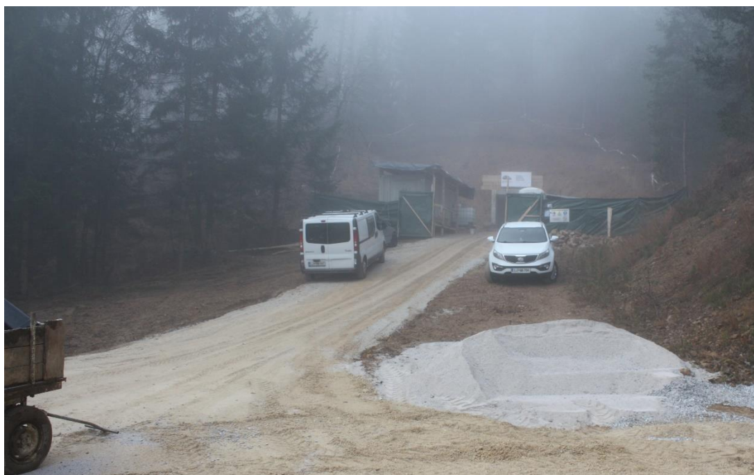
Slika 2.3 – Ureditev klančine med spodnjim platojem in lokacijo pred vhomom v jamo
