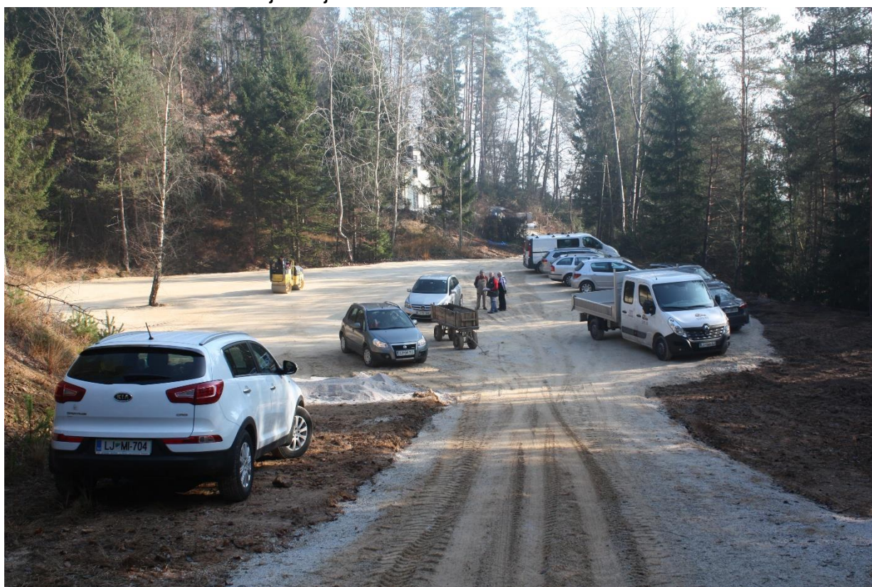
Slika 2.1 – Ureditev spodnjega dela platoja (pogled od portala proti vzhodu)
