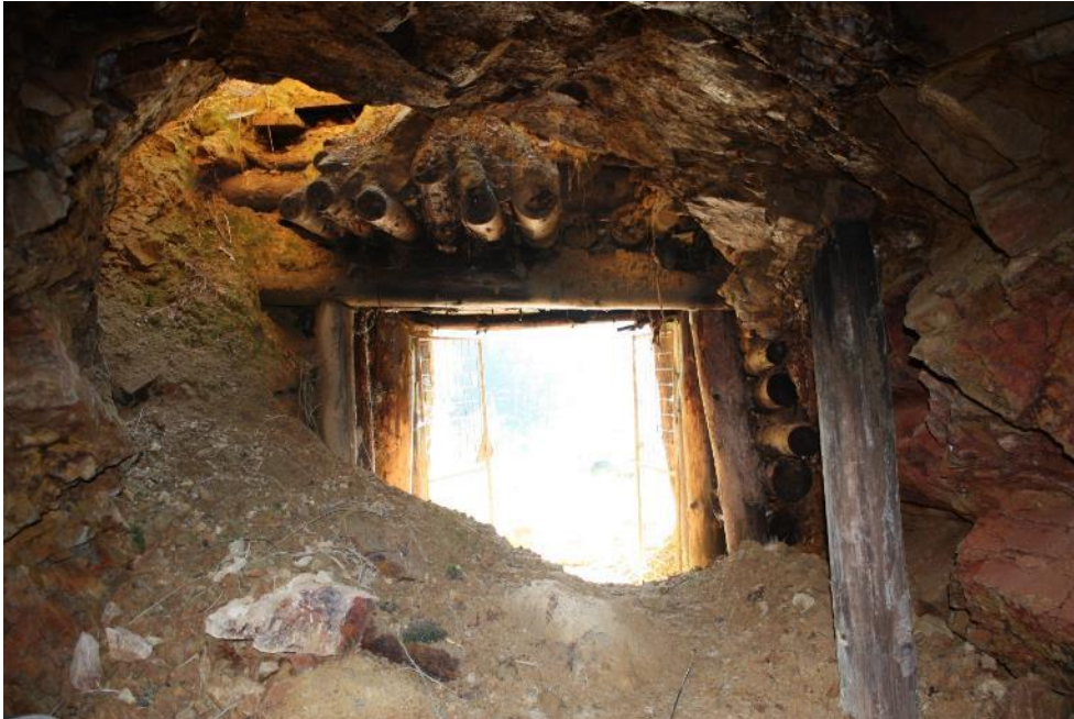
Slika 1.3 – Zrušen material z odprtino nad vhodnim delom (avgust 2016)
