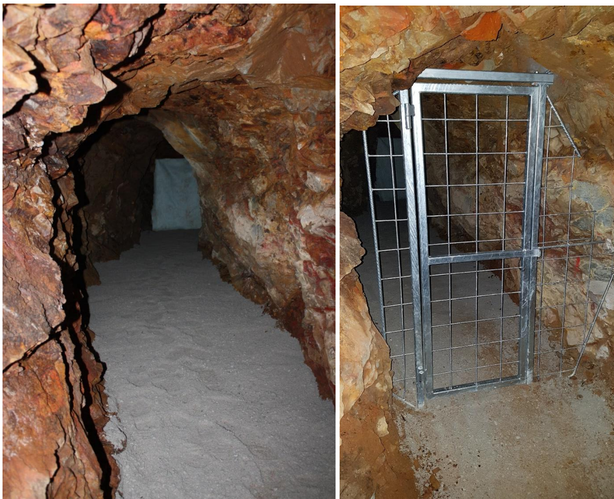
Slika 3.6 – Slepa proga od Objekta 2 proti SZ z ograjo + enokrilna vrata
